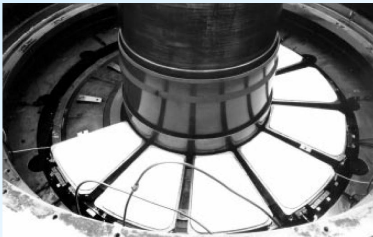
ot. 2. Widok warstwy ślizgowej łożyska z polimerową warstwą ślizgową: a) z warstwą pośrednią z drutu brązowego lub miedzianego, z warstwą pośrednią ze spiekane go brązu.
